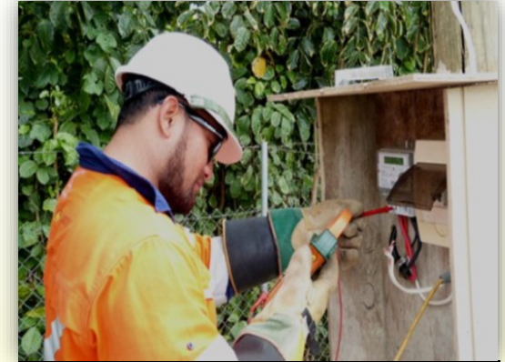
Ko hono fokotu'u ena 'a e mita 'uhila ka e fakahoko 'a e ma'u'anga ivi 'uhila.
